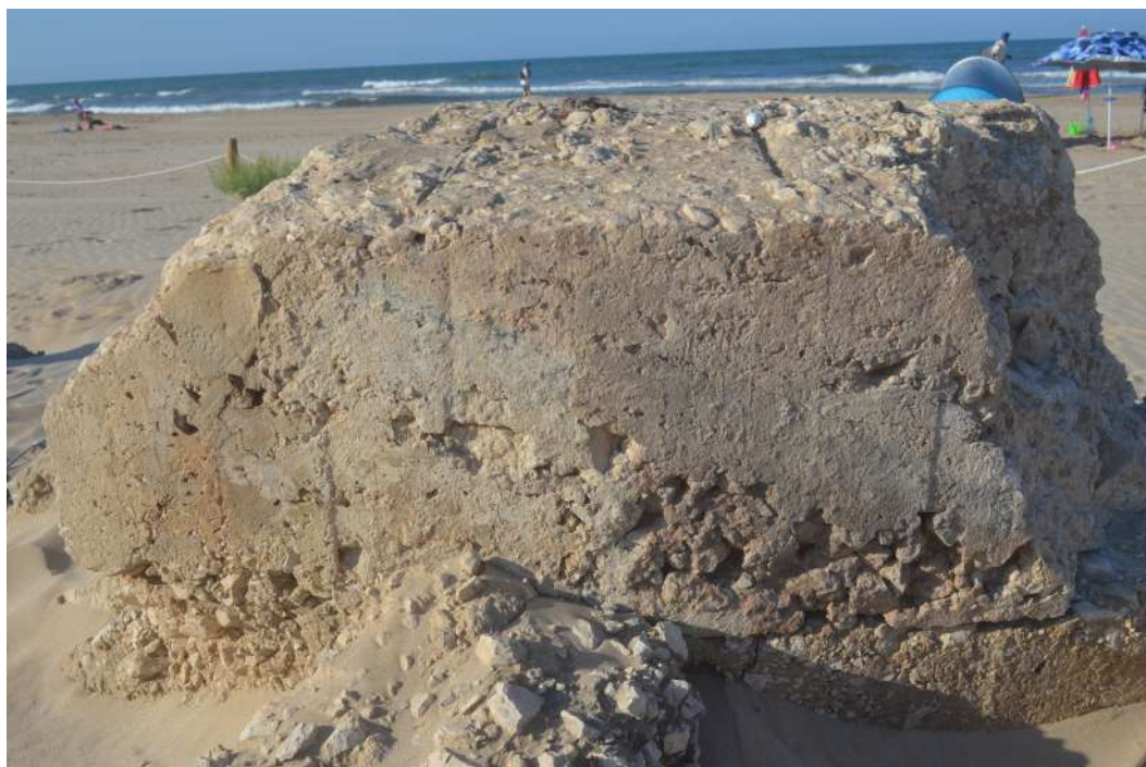
A.M.G. 005. Fotografia de detall. Taulons d'encofrat. Casamata el Molinell Oliva.
